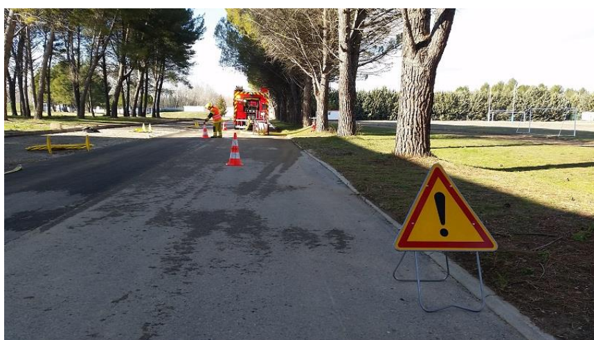
Illustration n°3 : Sécurisation de la zone de travail (Crédit photo @ ENSOSP)
