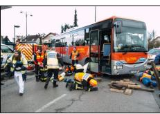
**1.** Mise en place de lits de cales de part et d'autre de l'essieu pour assurer <u>la stabilité</u> du bus
