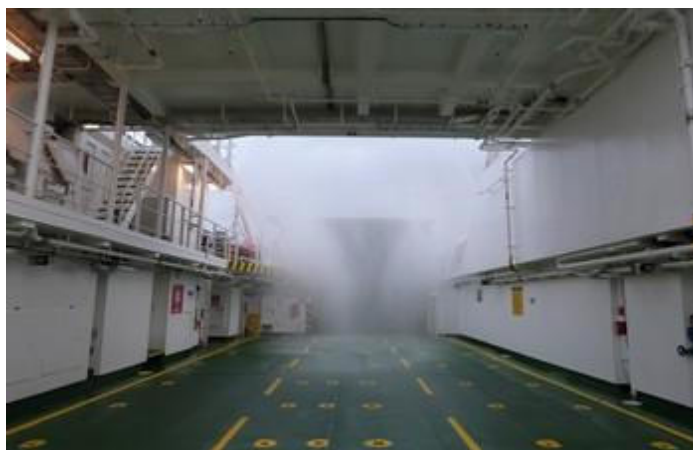
Drencher en eau sur pont garage
