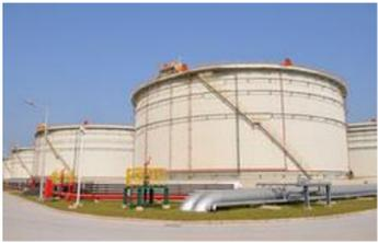
Réservoirs à toit fixe ou flottant
