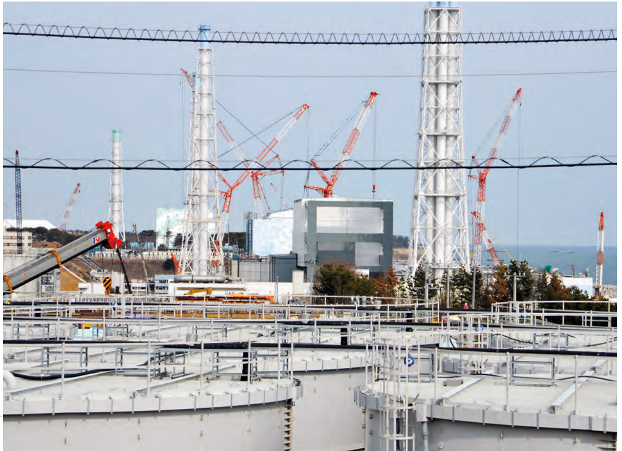
La centrale de Fukushima Daiichi, février 2015.
