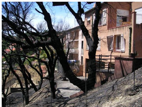
Dans ce cas de figure et malgré un front de feu réduit (départ du feu), le feu a rapidement pris de la puissance en se propageant sous forme de feu total. La propagation du feu en cime a impacté directement les maisons au niveau des fenêtres. Les volets plastique ont fondu et les rideaux intérieurs ont brûlé occasionnant des dégâts intérieurs. Un garage avec des poutres en bois a été détruit.
