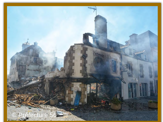
ARIA 51893 - 09/07/2018 - MORBIHAN Naf 35.22 : Distribution de combustibles gazeux par conduites
