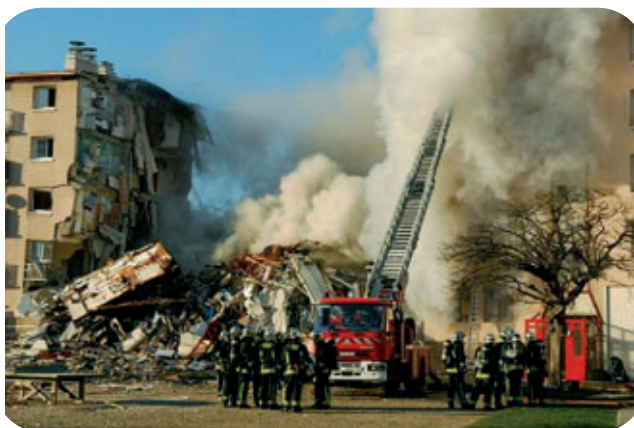
Explosion de gaz à Niort. Source : Internet
