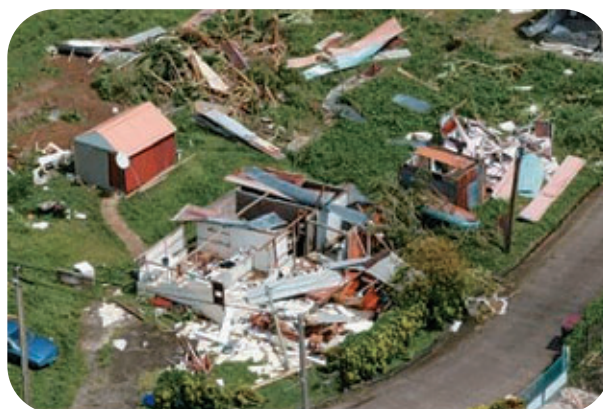
Habitations détruites suite au passage du Cyclone Dean à la Martinique. Source : DSC
