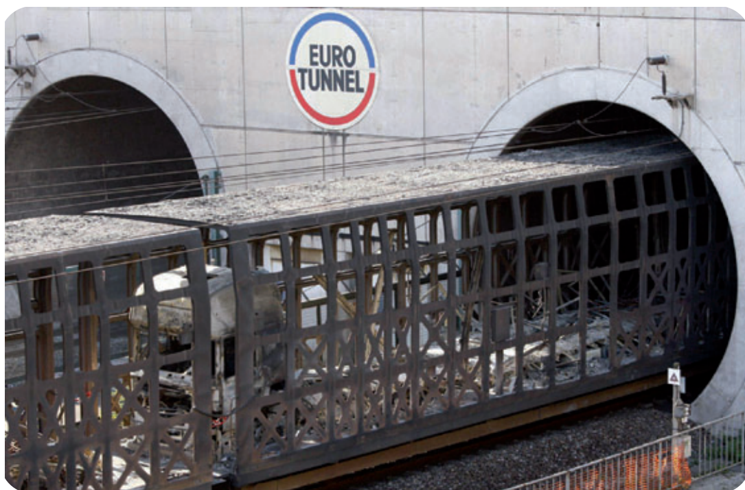
Sortie du tunnel de la navette détruite par l'incendie. Source Internet
